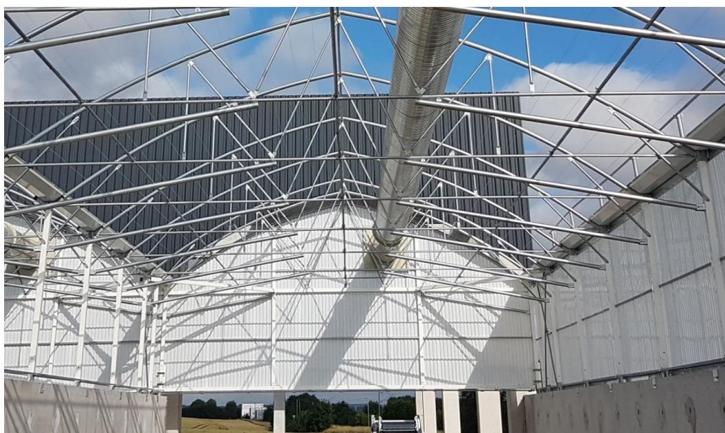
Illustration n° 11 : Structure des tunnels de fermentation Biodômes
